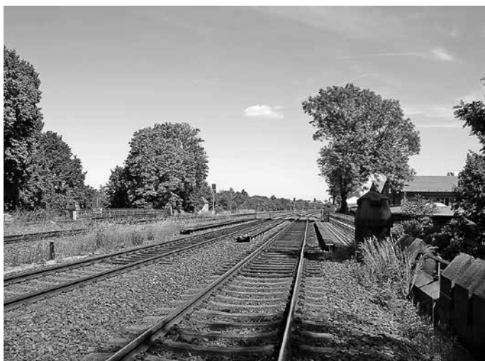
Kilometer 1,3, Blick über die Eisenbahnüberführung in Richtung Görlitz
