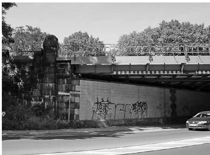
Die Überführung, die die Straße teilt – links die Rauschwalder Straße, rechts die Reichenbacher
