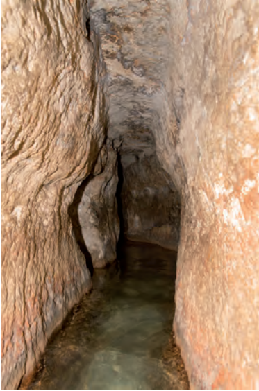
› Blick in den Hiskiatunnel.
