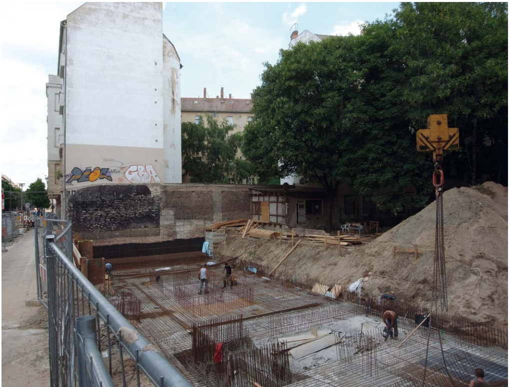
Abb. 6.1: Die Kellersohle steht
