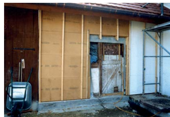
Zur Abdeckung der Außendämmung vor dem seitlichen Anbau wird eine naturbelassene Lärchenschalung mit integrierter Naturholztüre (Kiefer) ausgeführt [A].
