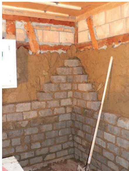
Da im Raum keine anderen feuchtigkeitspuffernden Materialien vorhanden waren, wurde eine Innendämmschale aus aufgemauerten Leichtlehmsteinen ausgeführt. Als Deckputz wurde über den Lehmsteinen ein Kalkputz mit abschließender Kalkglätte ausgeführt [C].
