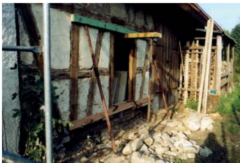
Das gesamte Wandfeld wird seitlich abgestützt und die losen Natursteinfundamente ausgegraben [A].
