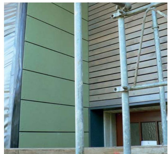
Nachdem die bestehende Mauerwerkswand mit weicher Holzfaserdämmung überdämmt wurde, wird ein Holzrost mit Winddichtung ausgeführt und die Fassadenschalung als Witterungsschutz aus vorvergrauter Lärche und Leichtbauplatten ausgeführt [E].
