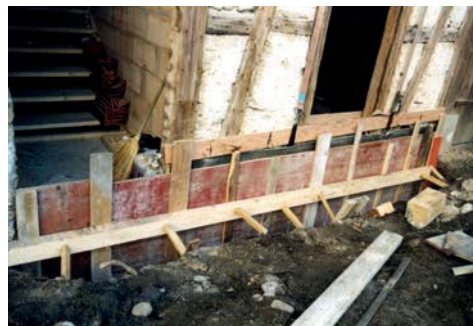
Ein neuer Eichenschwellenbalken wird eingebaut und anschließend frosttief (80 cm) unterbetoniert [A].
