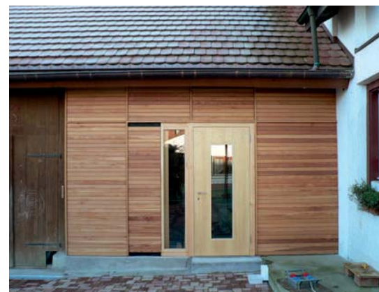
Zur Abdeckung der Außendämmung vor dem seitlichen Anbau wird eine naturbelassene Lärchenschalung mit integrierter Naturholztüre (Kiefer) ausgeführt [A].
