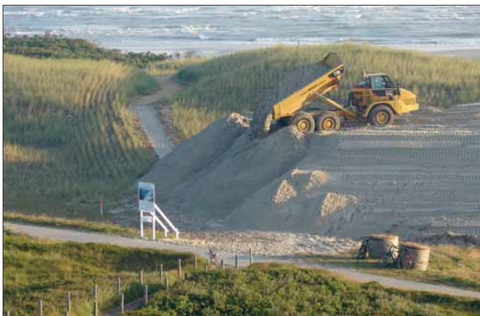
Abb. 3: Harter Uferschutz auf Spiekeroog mit Spundwand und verlorenem Strand (oben) und weiche Dünenverstärkung mit angefahrenem Strandsand auf Langeoog (unten) (Aufn. Karsten Reise, 2007).
